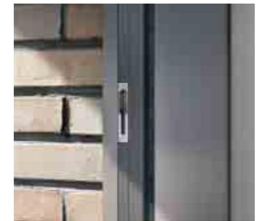
Mit der nahezu flächenbündigen Verriegelung im Blendrahmen werden technische Details unsichtbar.
